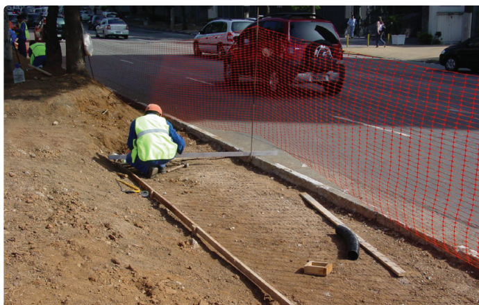
Barras de contenção de madeira
