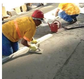
2. Contrapiso: aplique o concreto na superfície.
