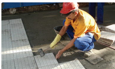
Assentamento do ladrilho hidráulico
