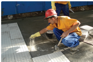
Salgamento com cimento
