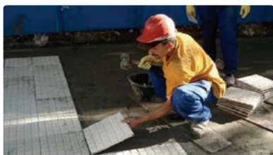
Colocação do ladrilho hidráulico
