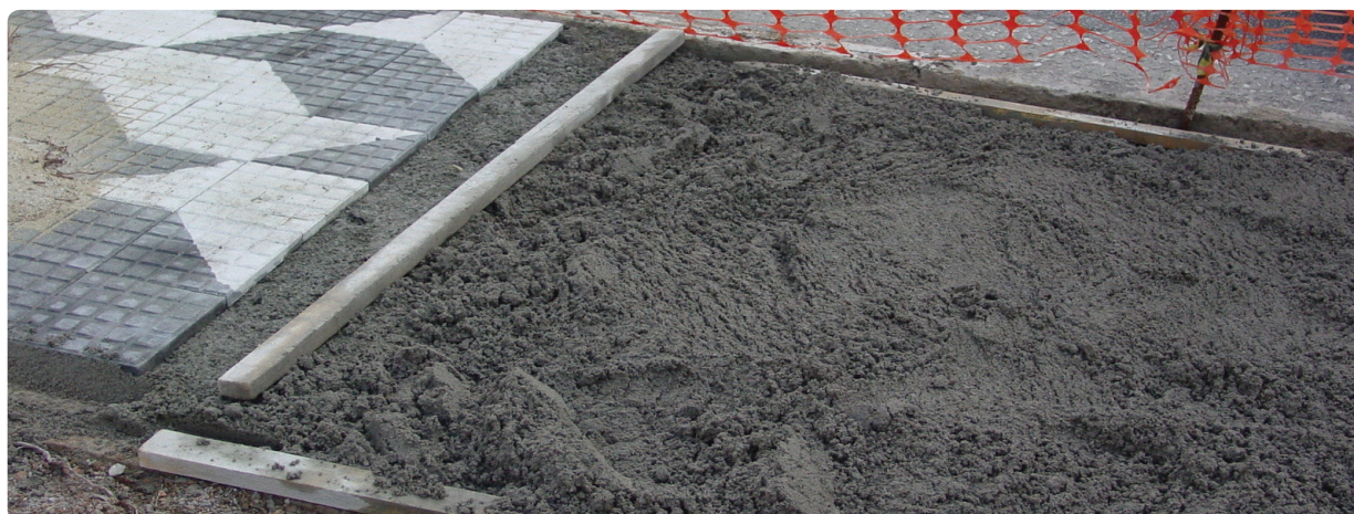
Assentamento utilizando argamassa tradicional
