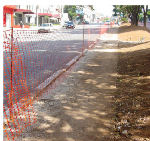
1. Umedeça a camada granular.
