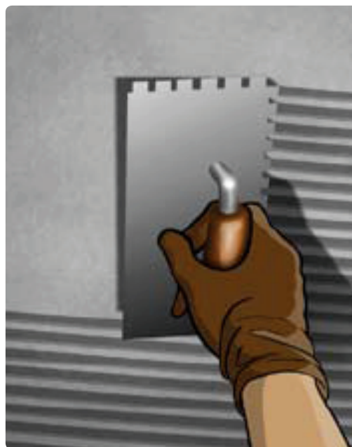
Raspagem com desempenadeira metálica
